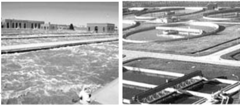
Gambar 7.6 Pengolahan Limbah dengan Proses Lumpur Aktif
